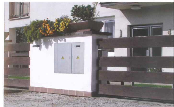
provedení - do výklenku, do zděného pilíře
